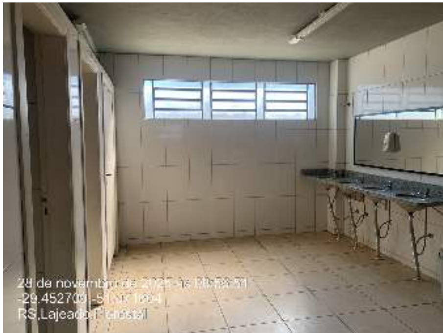
Vista interna do pavimento térreo - banheiros.
