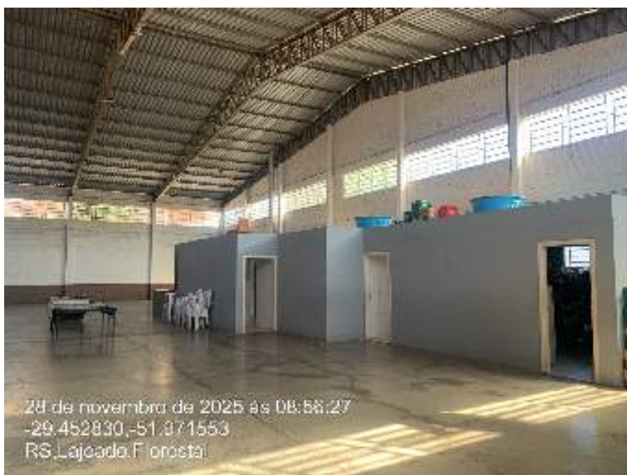
Vista interna do mezanino – Sem utilização atualmente.
